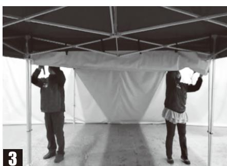
③隣接させたテントにも同様にクリップをトラスに掛け、天幕を雨樋の幕で挟むように設置します。
