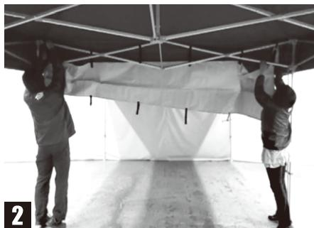
②トラスと天幕の間からベルトを差し込み、クリップをトラスに掛け、雨樋を吊るします。
